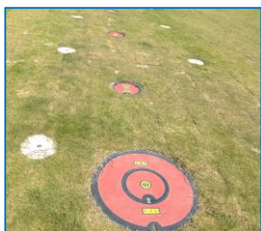
【マンホールトイレ 設置箇所】
